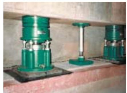
**Tellerfeder TFD unter einem Fundament mit Stützelementen**
